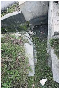
鄭東和發現SK11/4路一帶的溝渠已經阻塞,必須盡快提升,以免發生閃電水災。
